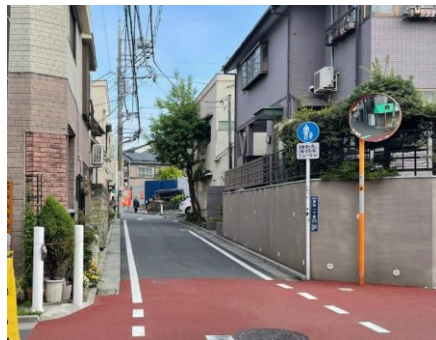
注意喚起シート未設置カ所 注意喚起シート無 ※入亀前
