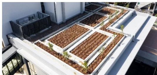
屋上緑化による断熱効果の向上
